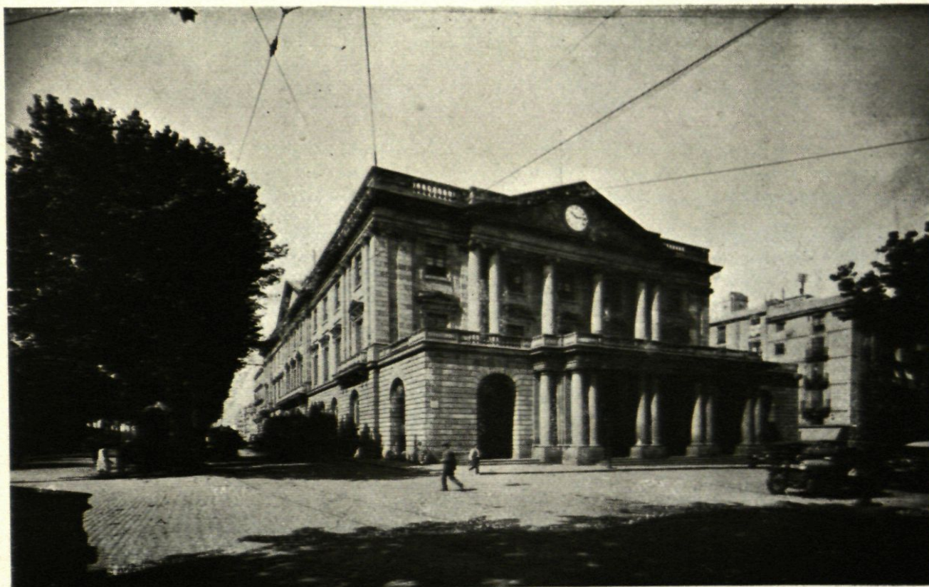
Fig. 13. — Vista general de la Lonja desde la Plaza de Palacio, antes de la reforma del Paseo de Isabel II
