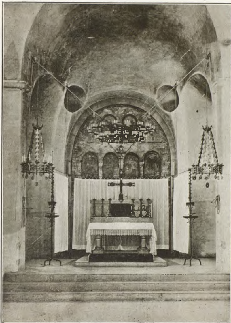
Sant Pere de Terrassa. —Restauració de l'altar. Rafel Masó, arquitecte.
