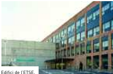
Edifici de l'ETSE.
