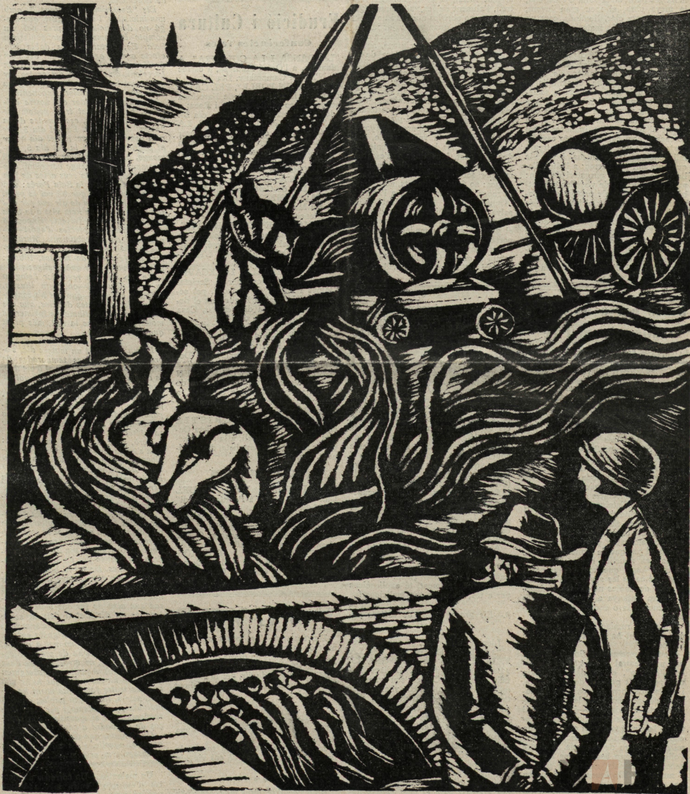
DAVANT LES OBRES DE LA PLAÇA DE CATALUNYA
