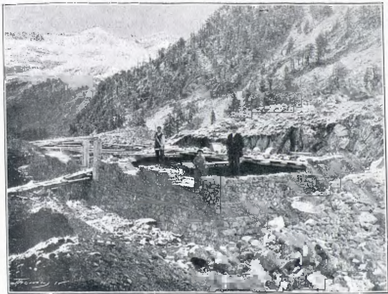
XALET-REFUGI DE LA RENCLUSA : ESTAT DE LES OBRES
