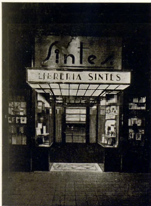
Perfecta instal·lació lluminica per als aparadors i façana d'una llibreria.
