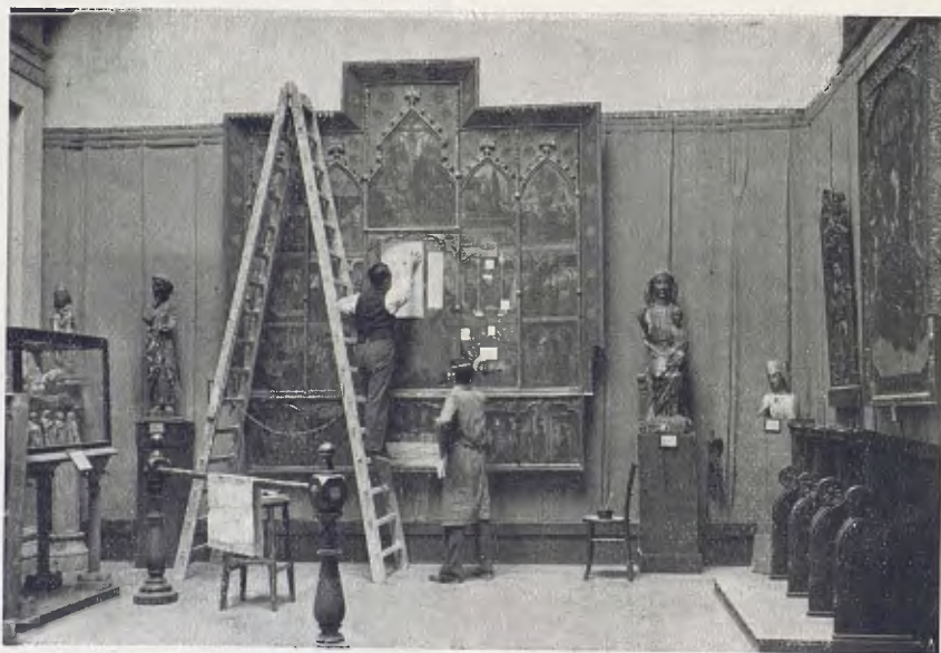
Desmuntatge de les instal·lacions de pintura i escultura gòtiques
