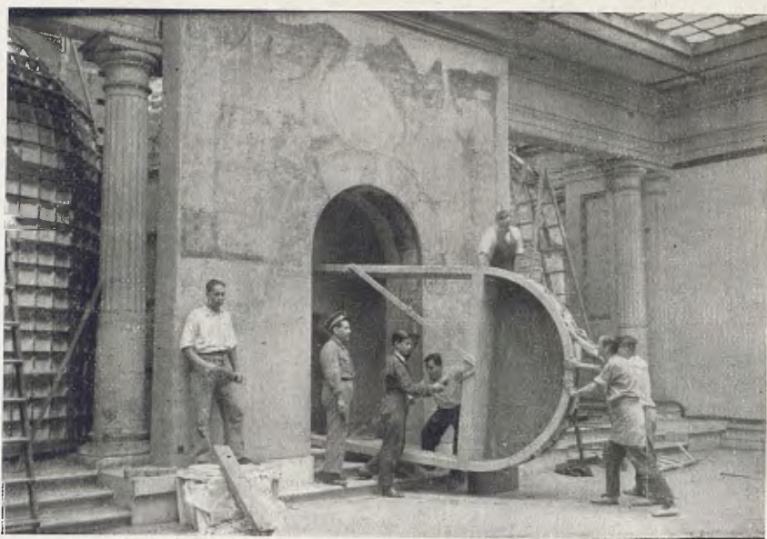
Desmuntatge de les instal·lacions de pintura romànica
