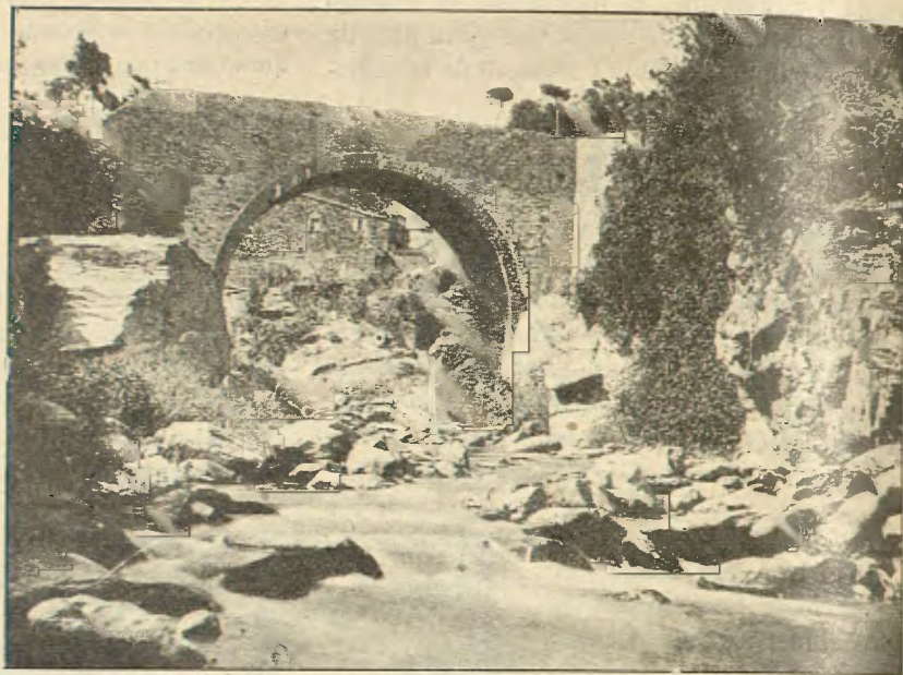
Pont de "Can Illa" sobre'l Tordera
