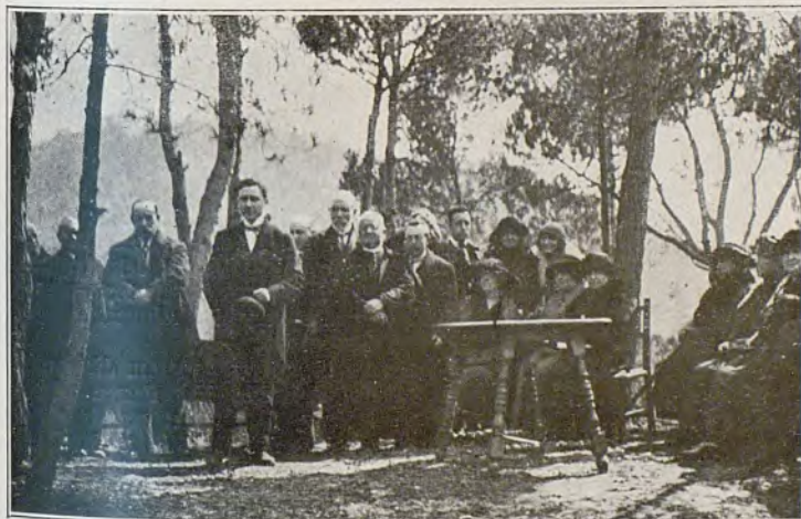
Inauguració de les obres de construcció dels pavellons per escoles de deficients de «Vilajoana» (Vallvidrera)
