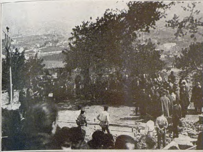
Començament de les obres de les Escoles a l'aire lliure del Parc Municipal del Guinardó
