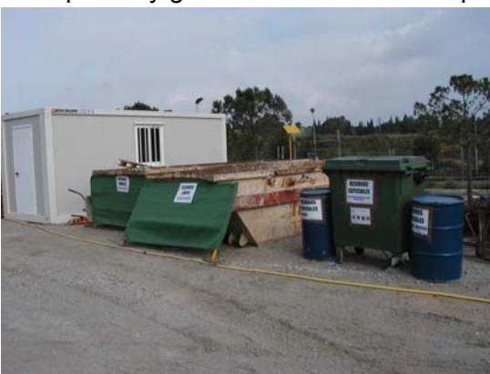
Para los **residuos no peligrosos**, las obras están dotadas de un contenedor para el escombro limpio y otro contenedor para productos banales. Los residuos orgánicos y asimilables a domésticos se depositan en contenedores dentro de la obra, y posteriormente se trasladan a los distintos contenedores de basura selectiva situados en la vía pública y propiedad del ayuntamiento.
