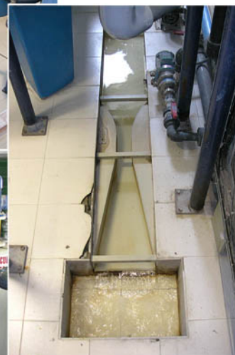
Canal Parshall de sortida de les aigües depurades (abocament final)
