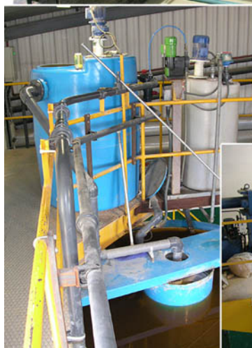
Dipòsit de floculació (superior) i decantador (inferior)
