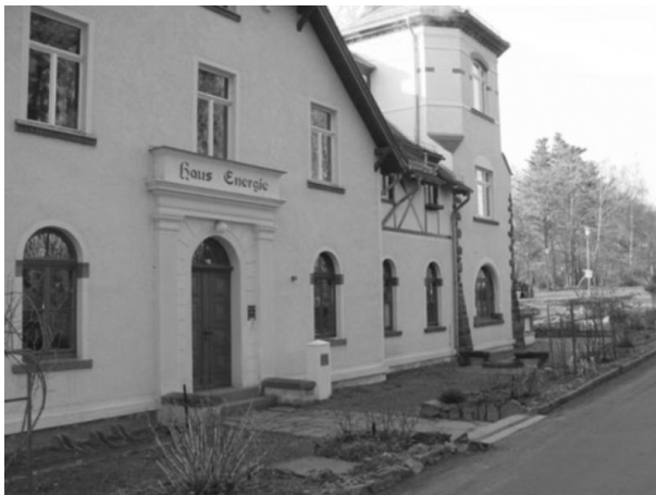
Casa «La Energía» de Ostwald en Grossbotten (Alemania).
