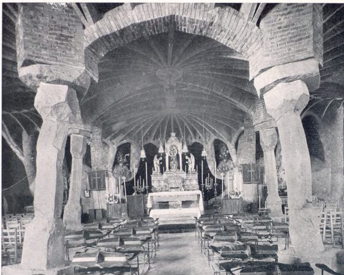
Interior de la cripta de la Colonia Güell con arcos y pilares en posición equilibrada
