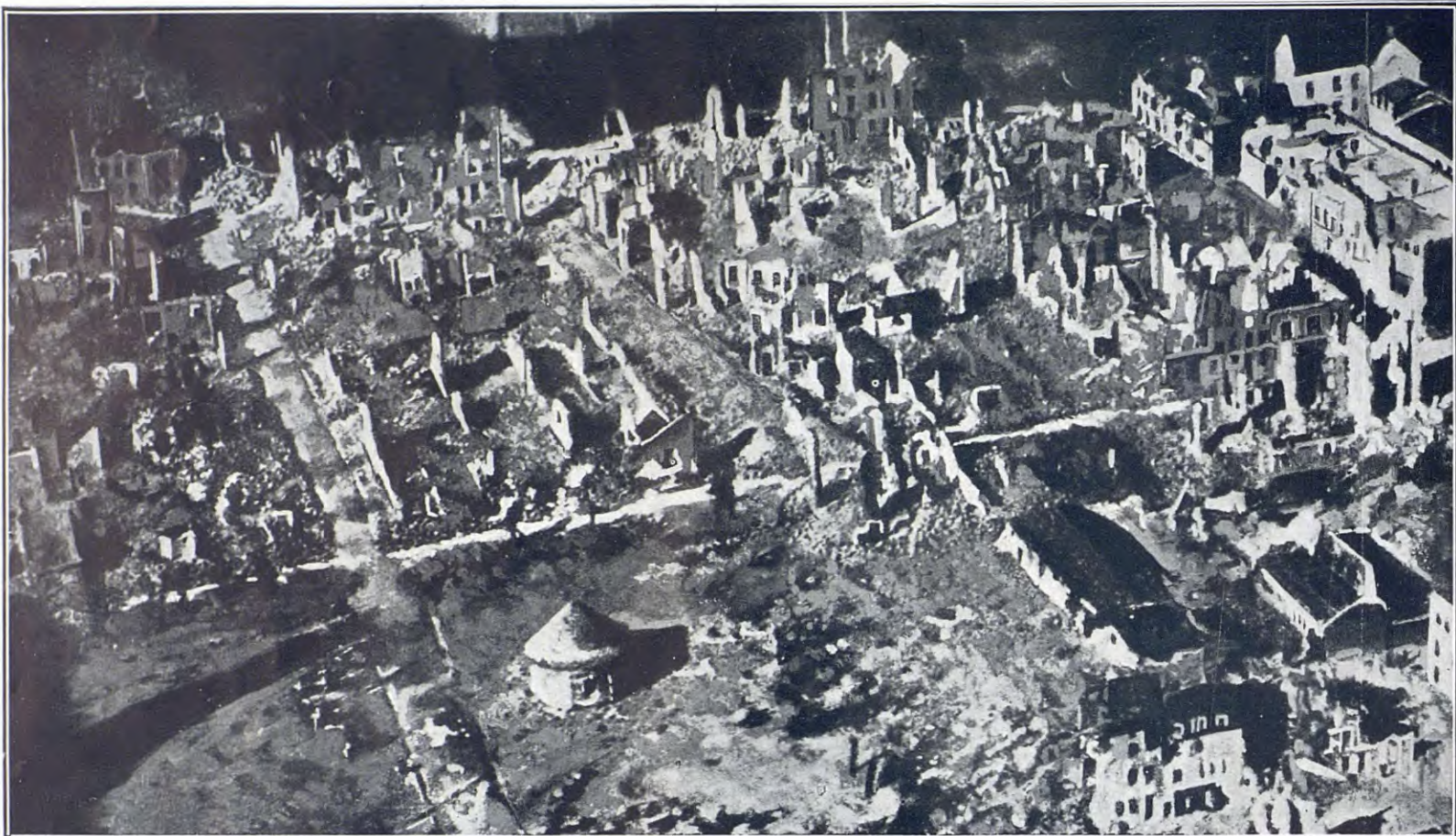
Fotografía de las ruinas de Longwy (Bélgica) tomada desde la barquilla de un zeppelin, y que muestra la total destrucción de la ciudad
