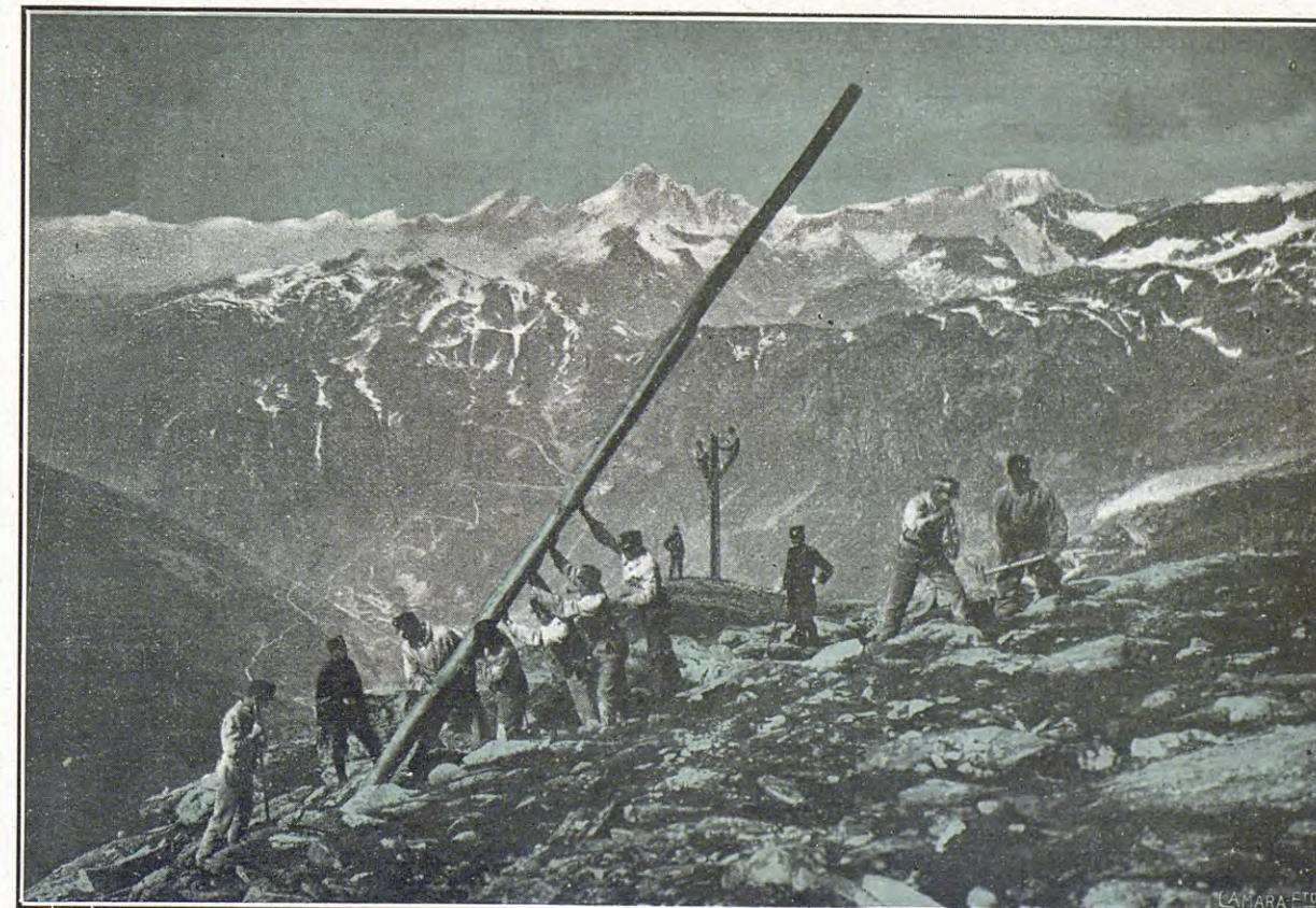
Soldados colocando un poste para la instalación de una línea telefónica
