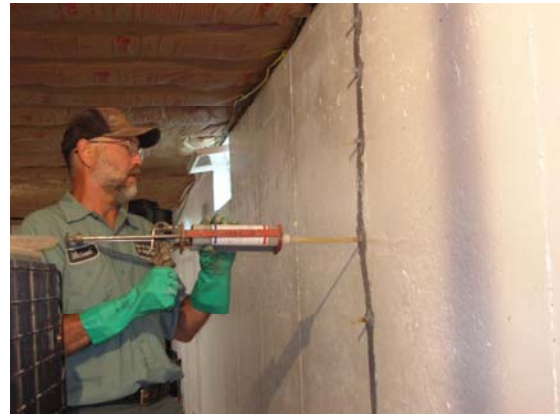
Figura 2: Inyección típica en grieta
