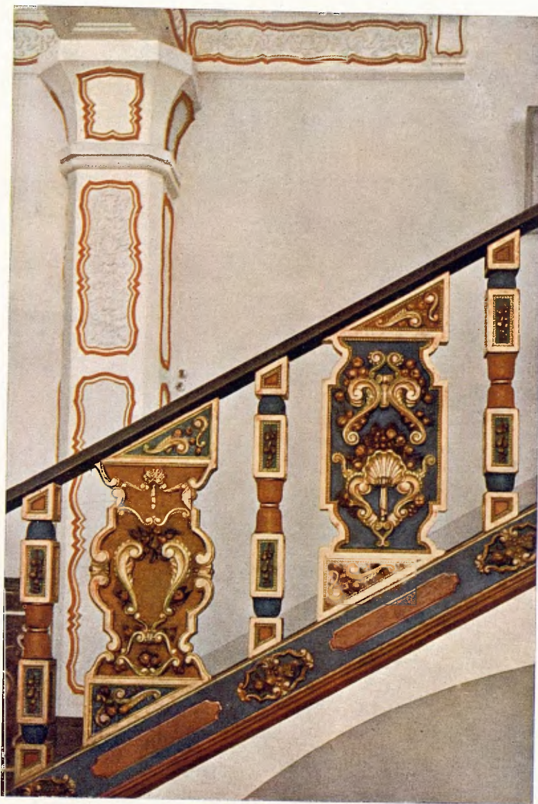
DETALL D'UNA BARANA D'ESCALA INSTALADA EN LES "GALERÍES PUIG"
