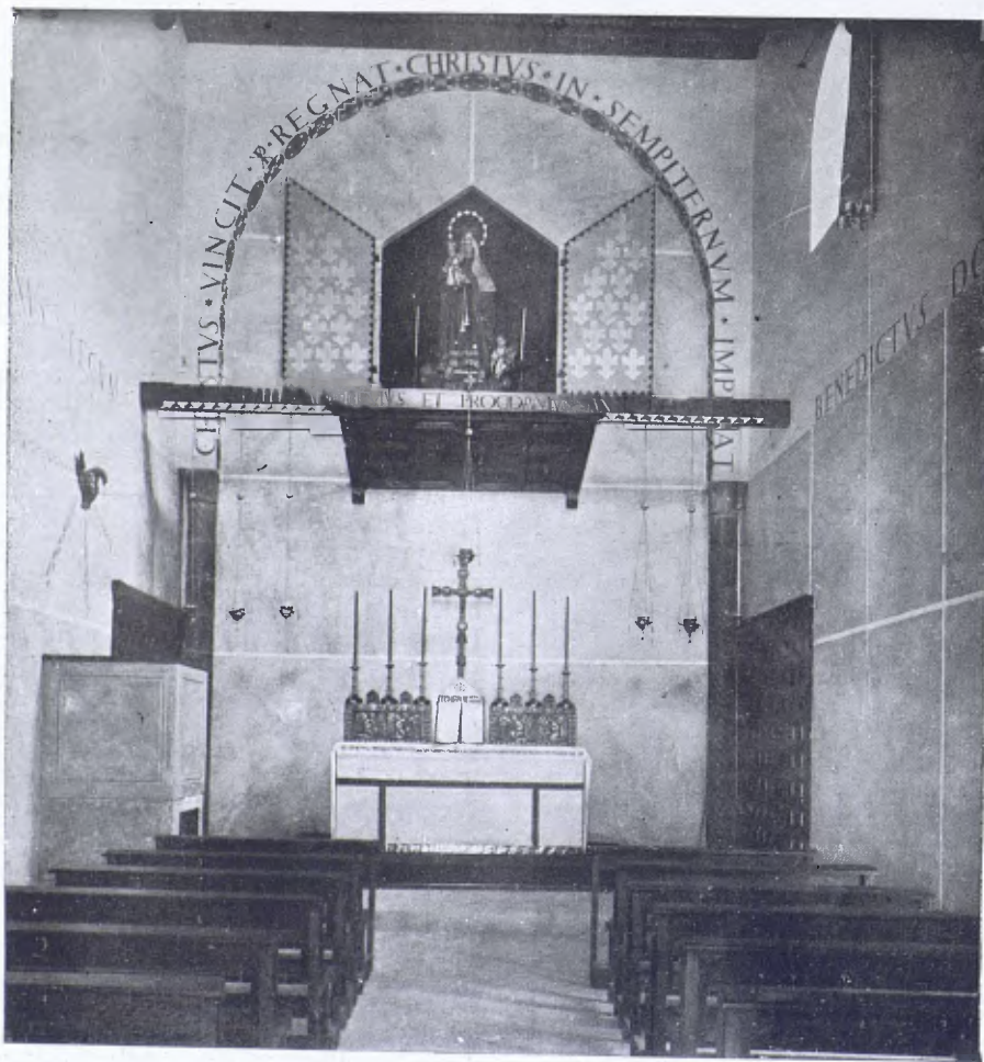
Església Conventual de Girona. Massó arquitecte. Execució Galeria dels Bells Oficis de Girona.
