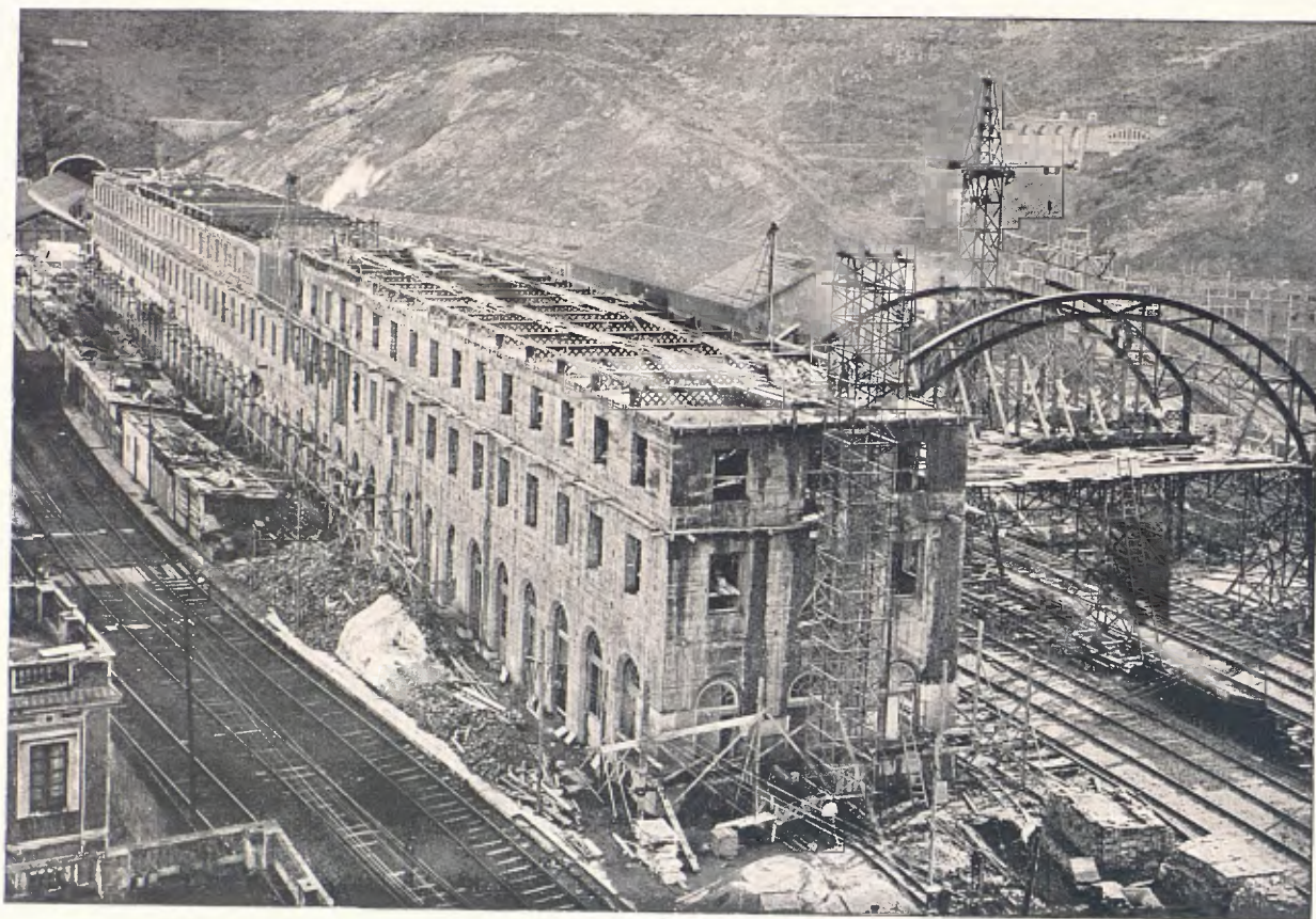
Obres de la nova estació a Port-Bou
