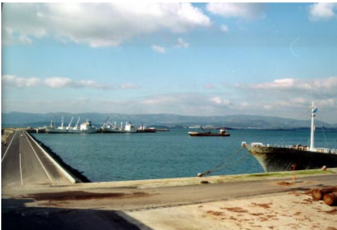
Nuevo acceso al muelle de Ferrazo
