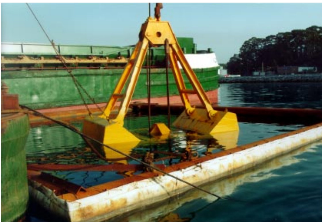
Dragado del canal de acceso al Puerto
