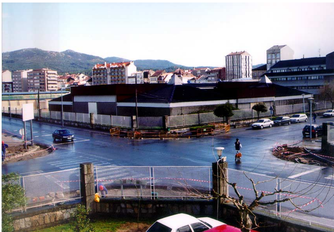
Construcción de rotondas en los cruces de vías portuarias
