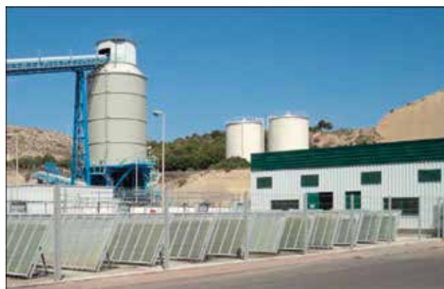
Central Térmica Litoral de Almería
