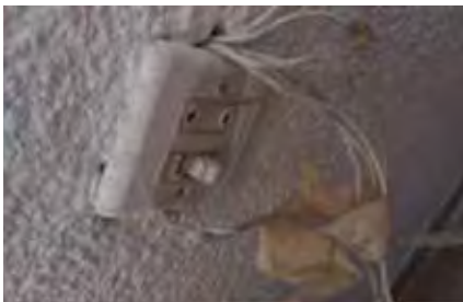
Doble mecanismo, conmutador/enchufe, obsoleto, sin acceso, detrás de la cabecera de la cama con derivaciones no adecuadas de circuitos.
