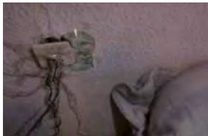
Enchufe detrás de la mesita de noche obsoleto, fuera de cajetín, con derivaciones de circuitos varios conectados sin garantía de conexión y con riesgo de contacto eléctrico e incendio.
