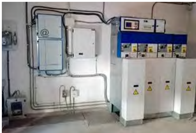
Centro de Transformación MT/BT totalmente automatizado y monitorizado incluido dentro del Proyecto MONICA, en SmartCity Málaga
