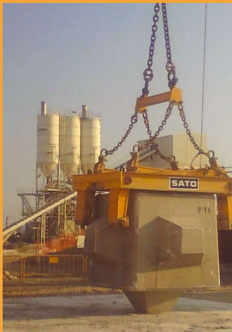
Sato, la filial de OHL especializada en obras marítimas, desarrolla el proyecto Cubipodo, en colaboración con tres universidades. Se trata de producir un nuevo elemento para la construcción de diques en el mar.
