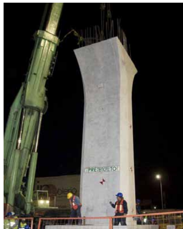
El cumplimiento de las obligaciones laborales es una de las mayores exigencias de OHL a sus subcontratistas. En la foto, colocación de una columna para soportar el Viaducto elevado Bicentenario en México DF
