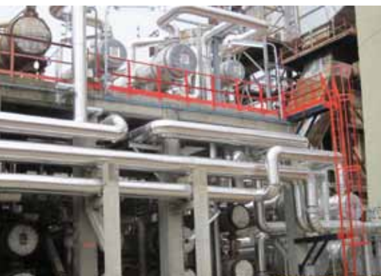
Detalle del tren de intercambio de crudo en combustibles de la refinería de La Rábida, cuya mejora energética ha sido desarrollada por OHL Industrial y ha merecido la felicitación del Cliente.
