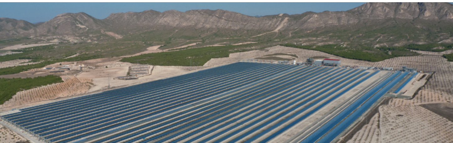
Planta de energía termosolar de Puerto Errado 2 (Murcia), es la mayor planta construida con tecnología de generación directa de vapor basada en colectores tipo linear Fresnel con escala comercial (30 MWe). OHL Industrial ha introducido importantes innovaciones en la misma, para hacer viable su funcionamiento.
