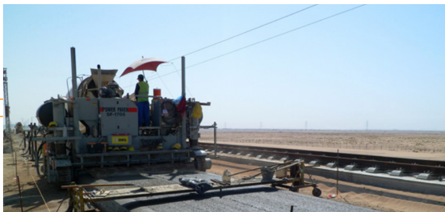
Campo de trabajo de OHL en la LAV La Meca-Medina (arriba) y trabajos para la instalación de vía en placa.
