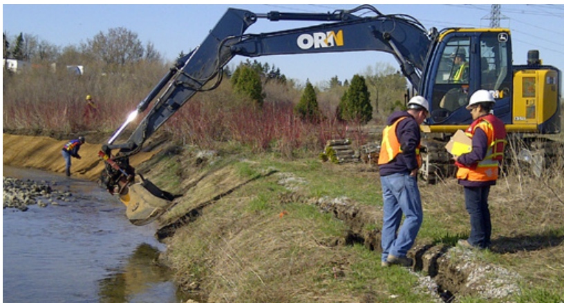
Estabilización de los bancos de Black Creek a lo largo de la zona de influencia de la obra.
