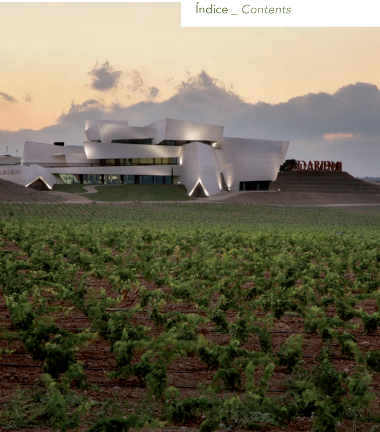
Bodegas DARIEN (La Rioja), en la que se han instalado los productos aislantes de URALITA. DARIEN winery (La Rioja, Spain), where URALITA Insulation products have been installed.
