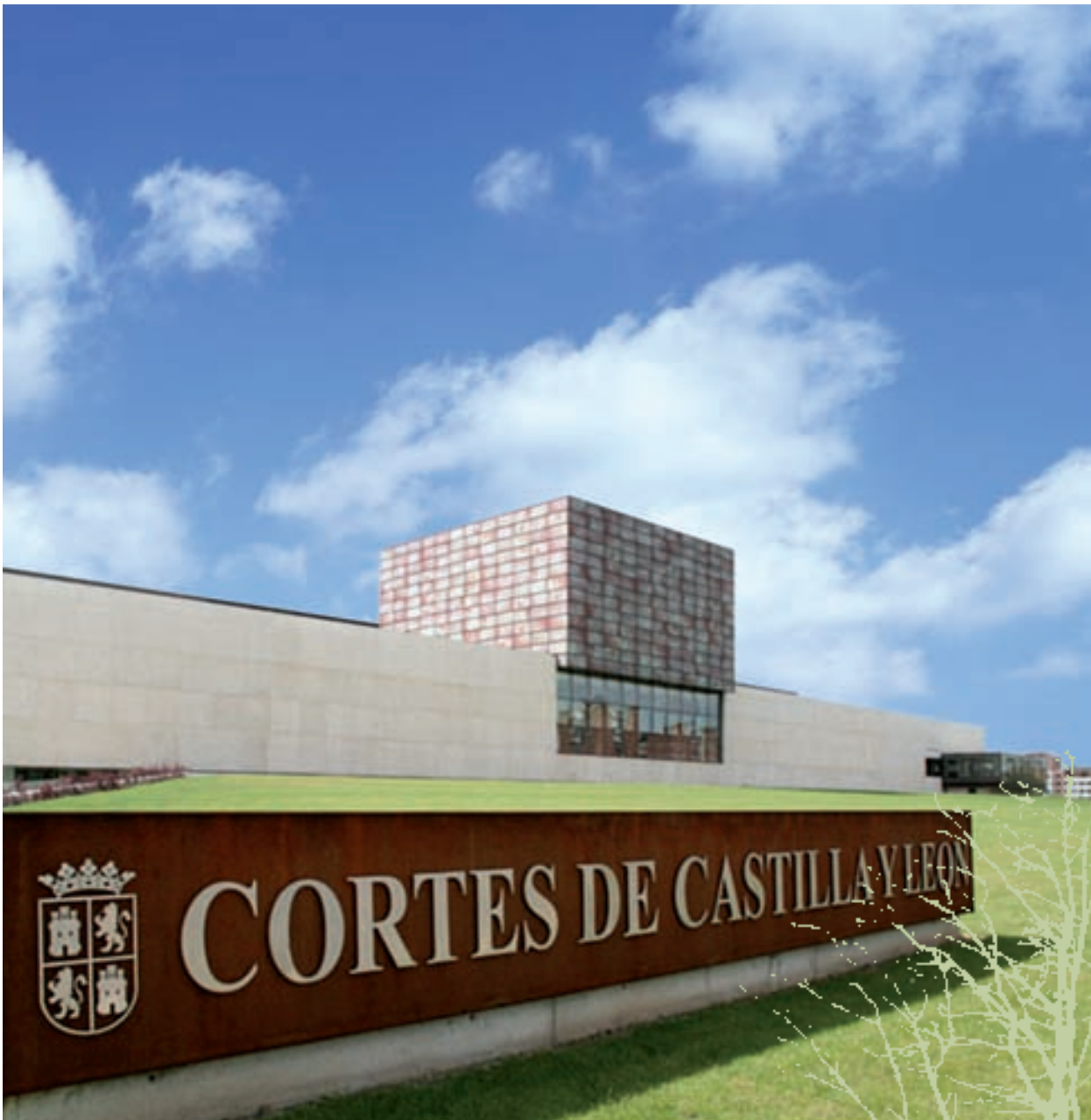
Edificio de la Junta de Castilla y León (Valladolid), en el que se han instalado los productos de placa de yeso; Pladur®, de URALITA. Castilla y León Regional Government parliament building (Valladolid, Spain), where URALITA plasterboard products have been installed.
