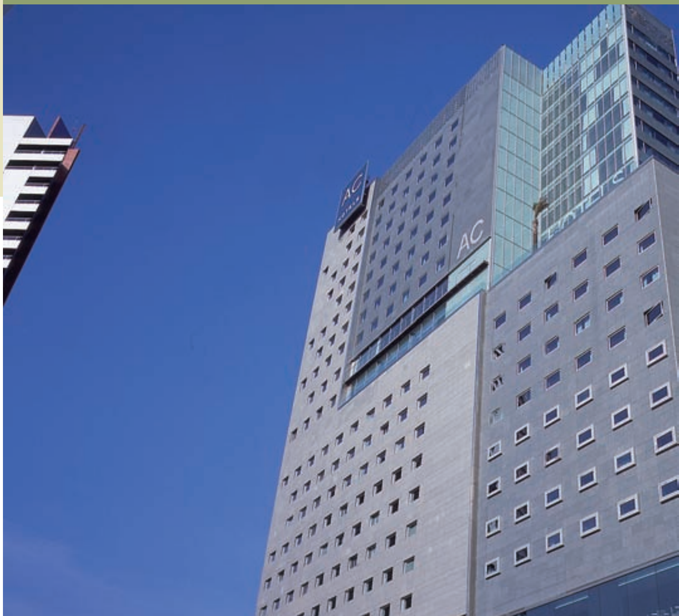
Hotel AC (Barcelona), en el que se han instalado los productos aislantes de URALITA. Hotel AC (Barcelona, Spain), where URALITA Insulation products have been installed.
