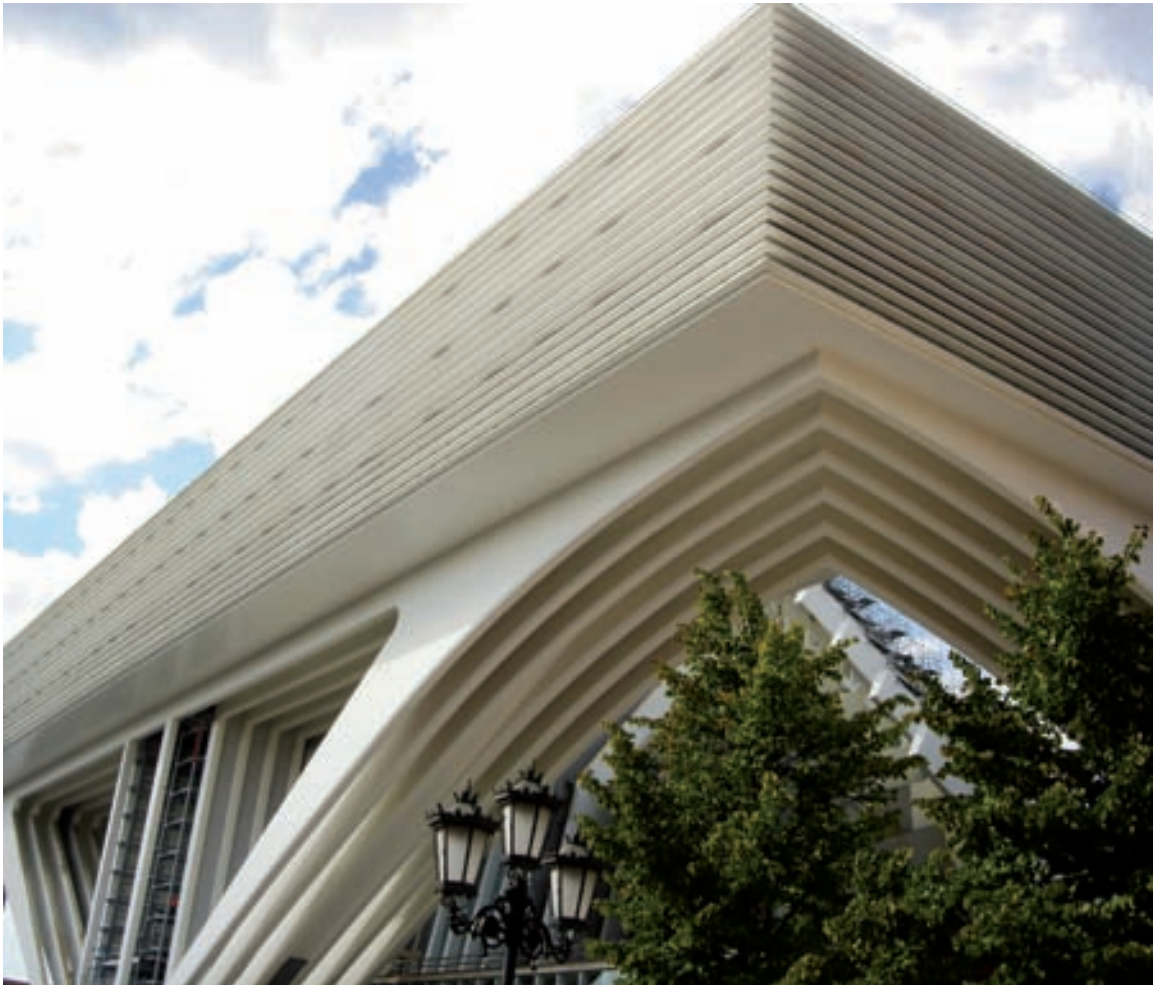
Palacio de Congresos (Oviedo), en el que se han instalado los productos de placa de yeso, Pladur®, de URALITA. Exhibition Center (Oviedo, Spain), where URALITA plasterboard products have been installed.
