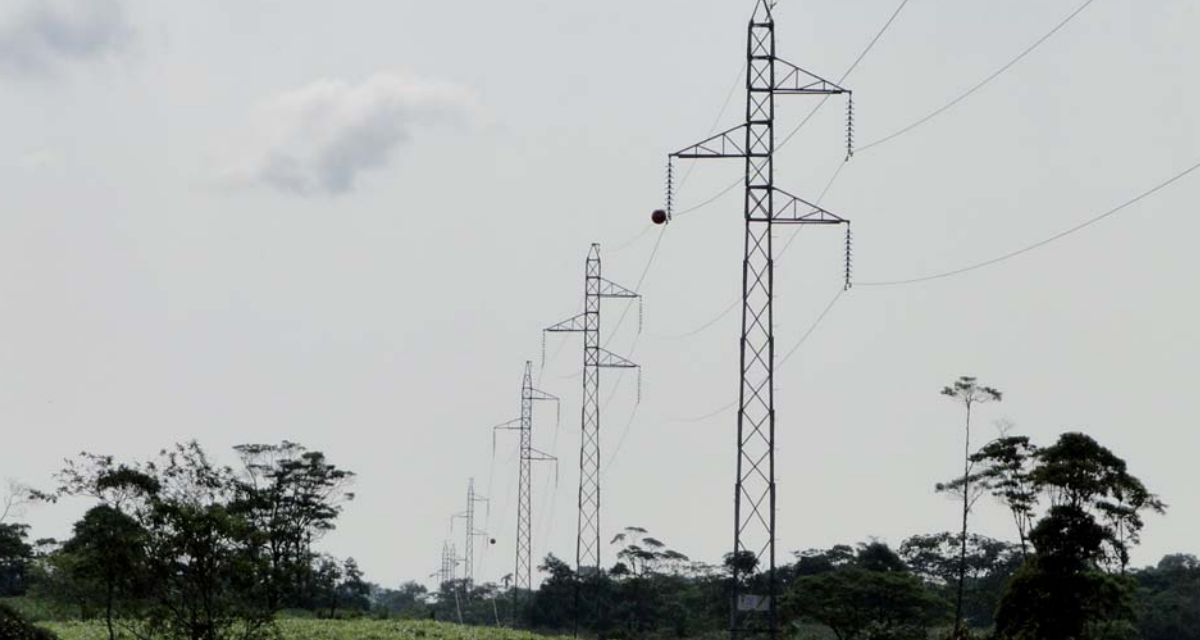
Línea de Subtransmisión Puyo–Mushullacta a 69 kV con aislamiento a 138 kV. 38 km. (Ecuador).
