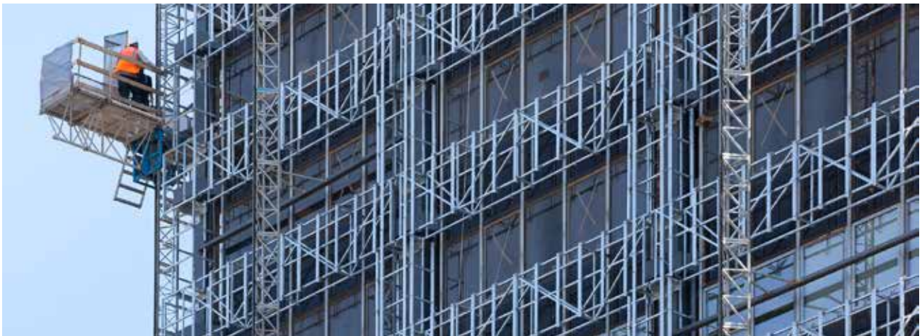
Rehabilitación energética. Málaga (España)
