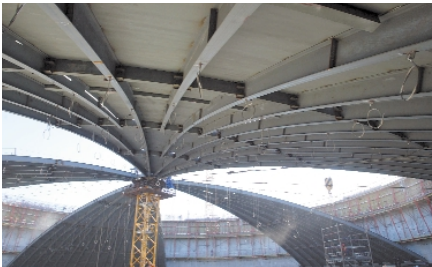
Reganosa: Construcción de la cúpula de uno de los tanques.
