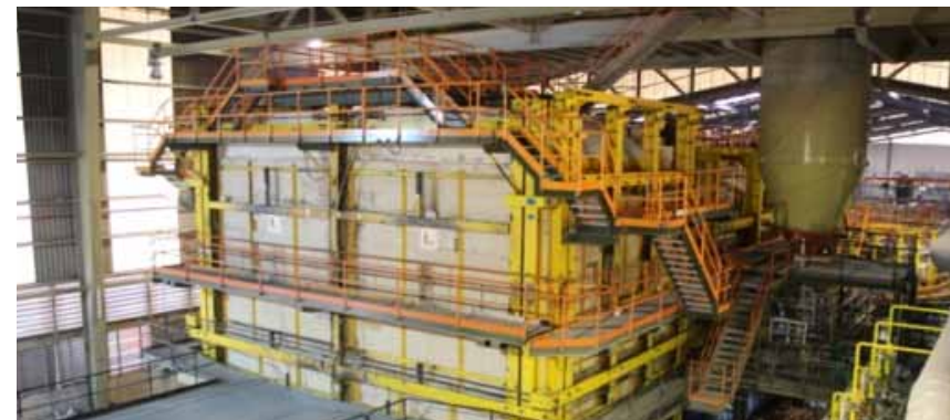
Nuevo horno instalado en Crisnova Vidrio.
