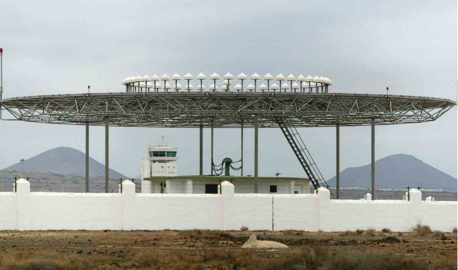
Aeropuerto de Lanzarote. DVOR/DME y torre de control Lanzarote Airport. DVOR/DME and control tower
