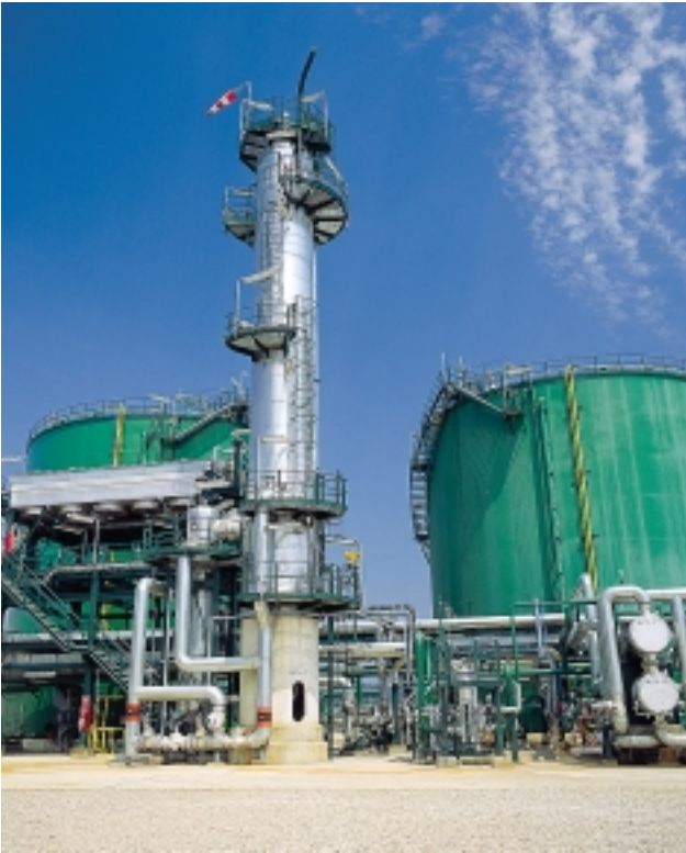
■ Instalaciones de eliminación de COVs de los efluentes de la refinería de Tarragona
