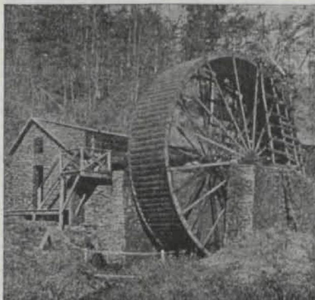
Rueda hidráulica de 12 metros de diámetro por 2,4 metros de ancho utilizada para accionar un generador eléctrico.
