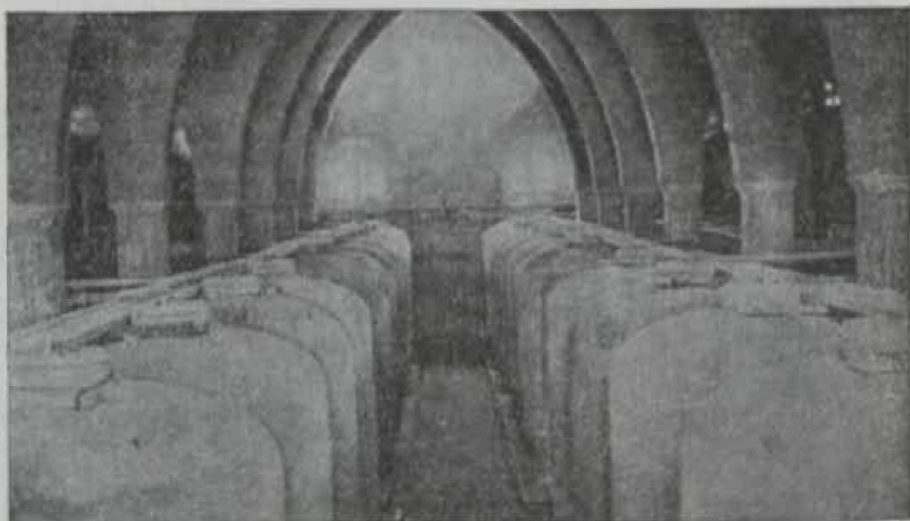
Recipientes vinarios de hormigón armado de 125 hectolitros de capacidad en la Bodega Cooperativa de Felanitx.
