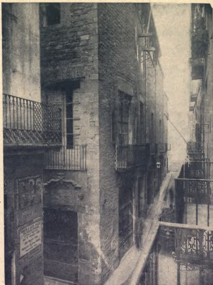
Façana del Palau Padellàs
