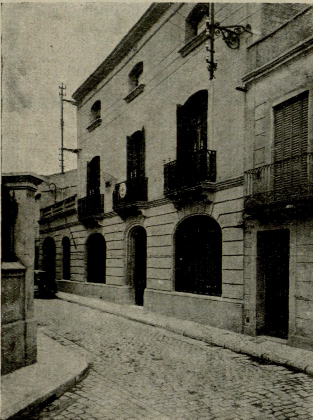
Mútua Sabadellenca d'accidents del treball i malalties. ● Façana.
