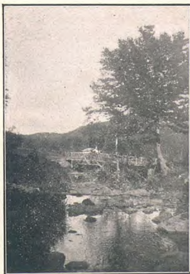
Passera de la riera de Sia, Fè—Fot. Armengol
