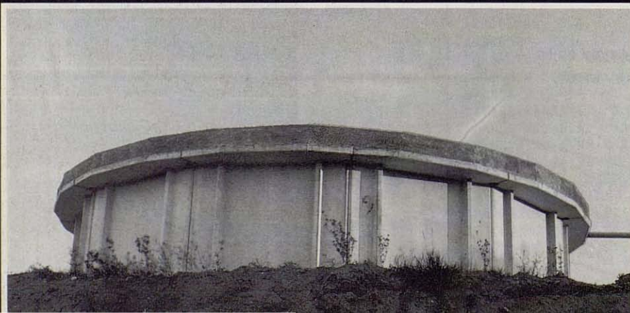
CUBIERTA PREFABRICADA DE HORMIGON: Económica y de gran rapidez de montaje; Aislante, muy resistente a los impactos e inalterable en ambientes agresivos.
