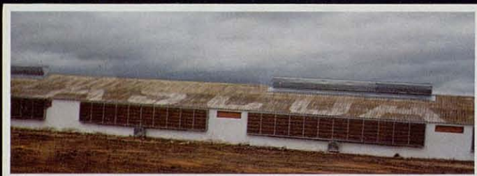
Refrigeración por extracción. Gallinas ponedoras, etc.
