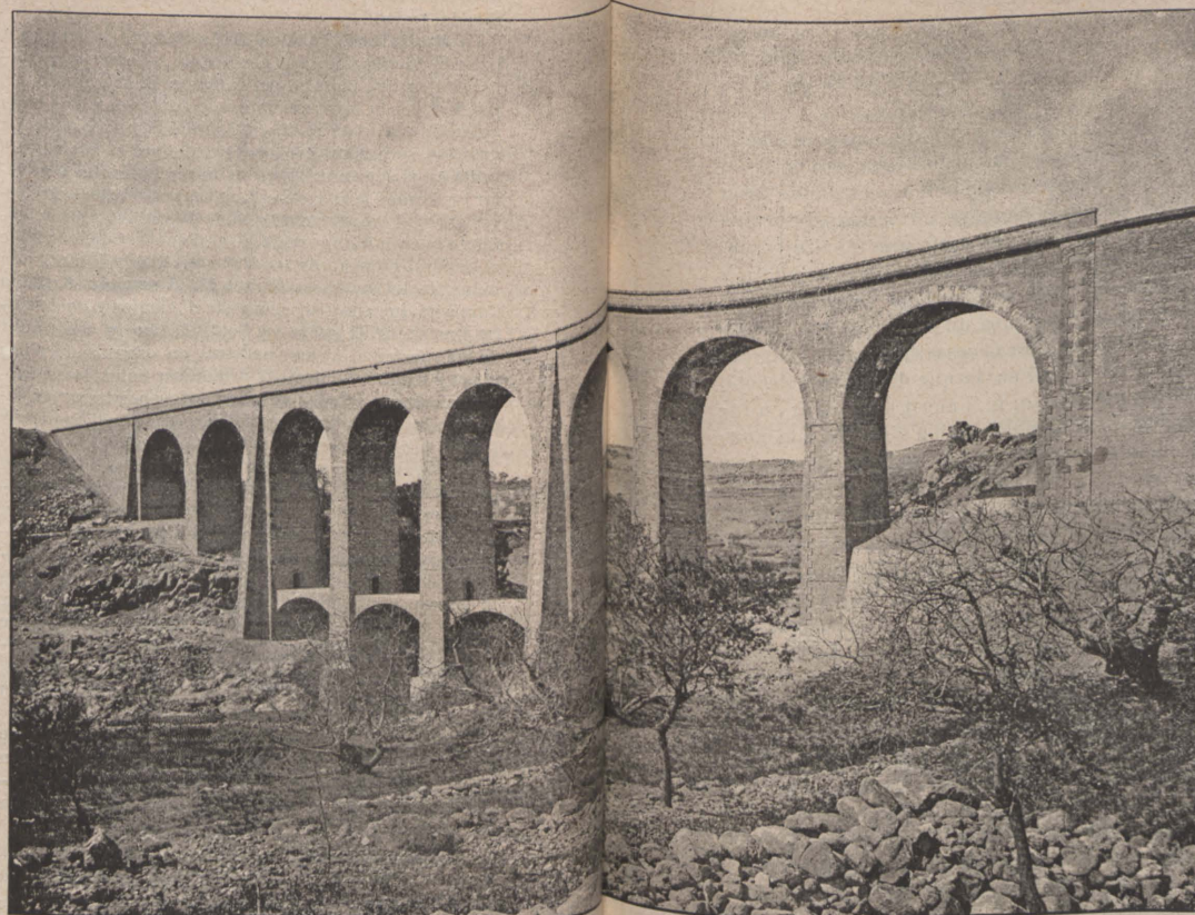
Viaducte de Capsanes
