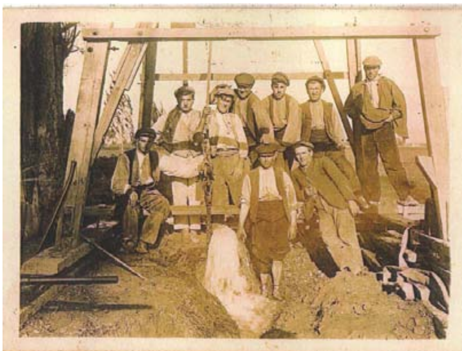
El Sr. Batllori Mata, el tercero comenzando por la izquierda, junto a sus compañeros en la construcción de un pozo artesiano.
