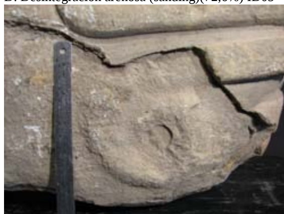
D. Desintegración arenosa (sanding)(72,6%) ID05
