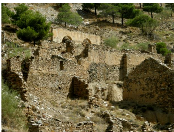
Poblat miner al vessant nord del Cerro del Gallo. Antigament, centre d'extracció de ferro
