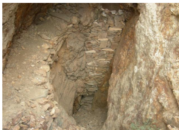
Apuntalaments d'una galeria exterior de les mines
