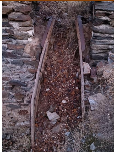
Canalització de sortida del rebuig de la tracció mecànica, al final de la rampa anterior
