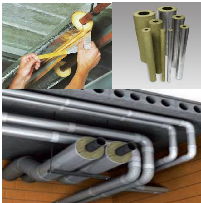
Figura IV – 1. Recobriments de llana mineral de roca per a canonades.
