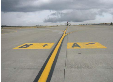
Figura 3.6 Calle de rodadura
