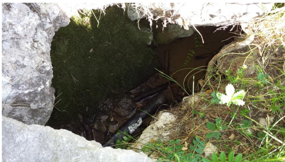
El punt de surgència de la font, on s'aprecia la infiltració en el terreny argilós
