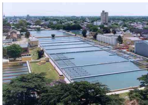
Imagen 6. decantadores @aguas santafesinas
