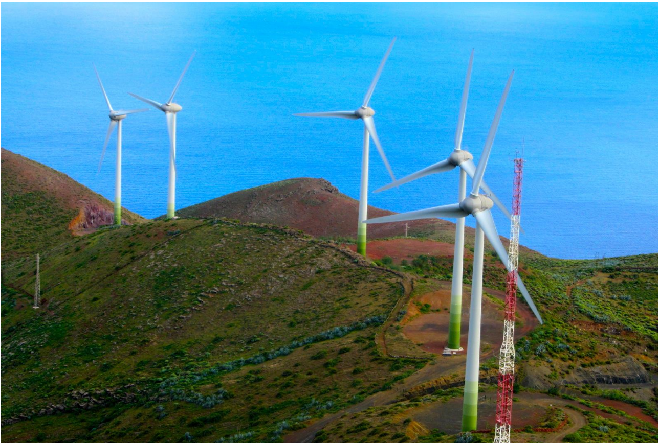
Aerogeneradores de la central Gorona del Viento de El Hierro. Fuente: elaboración propia
